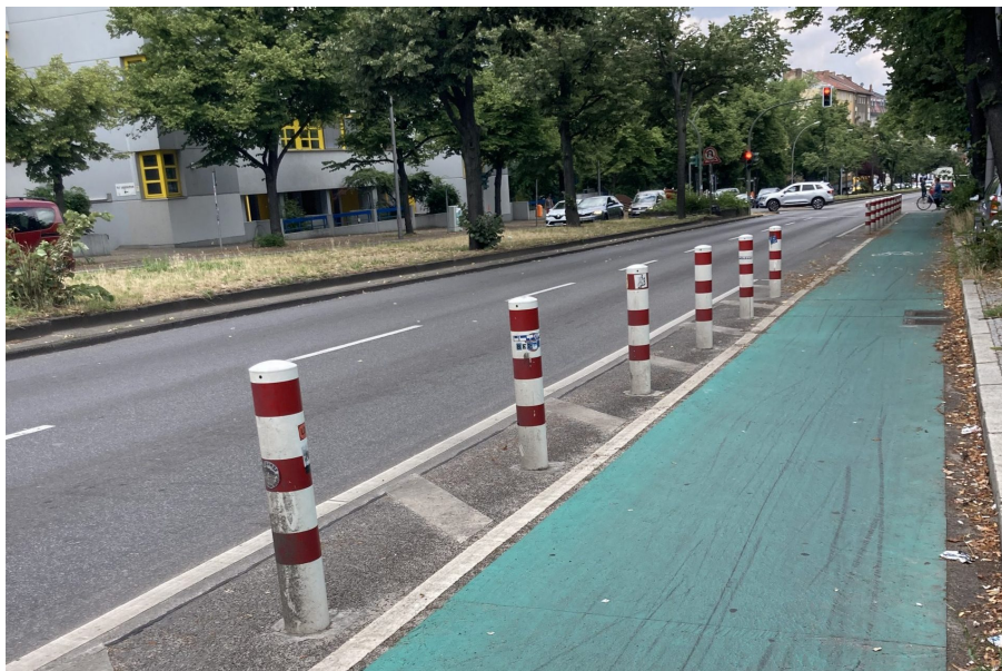
Abb: Beispiel für den Schutz einer Radspur gegen Kraftfahrzeuge (Berlin)
