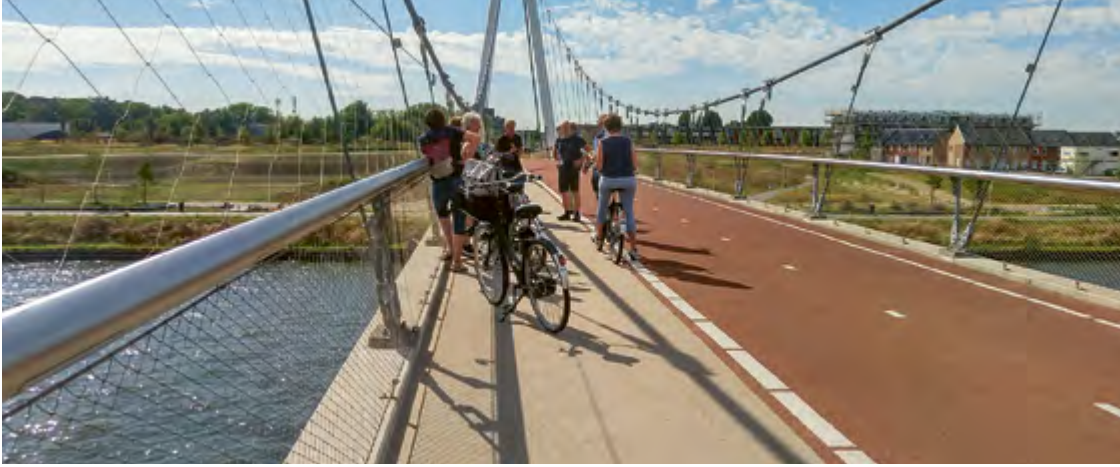
Fahrrad- und Fußgängerbrücke über den Amsterdam-Rhein-Kanal in Utrecht.
